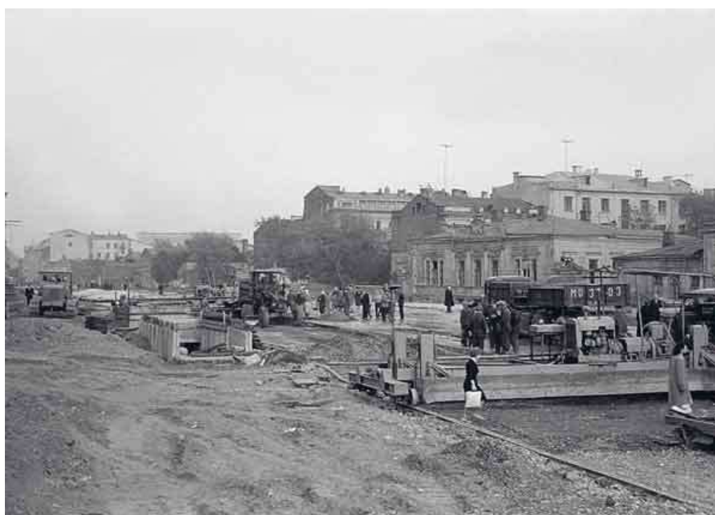
Фото 201. Строительство проспекта Калинина. Заасфальтированная Собачья площадка. На заднем плане видно здание Госпиталя.
