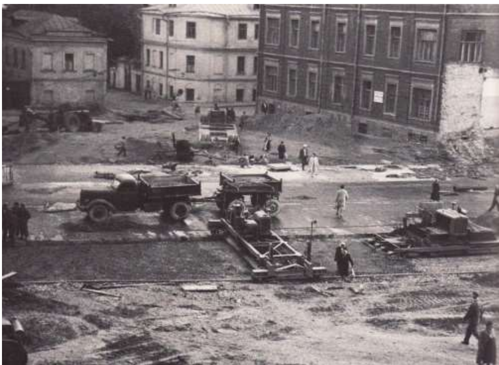
Фото 200. Снос Собачьей площадки и строительство магистрали.
