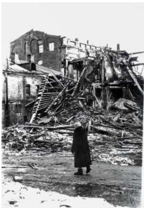
Фото 198. Вид на здание Госпиталя со стороны разрушенного Собачьего переулка. Остатки усадьбы семейства Олив. 1962 г.
