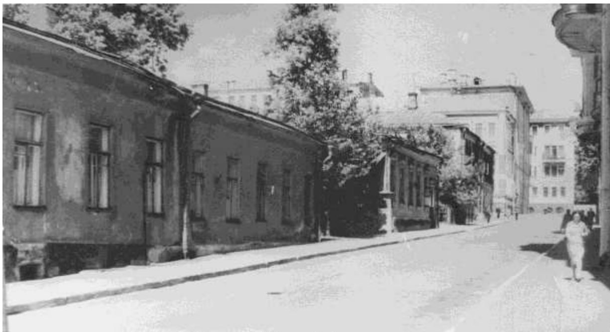
Фото 196. Снесенные здания по нечетной стороне Серебряного пер. Вид от Арбата к Б. Молчановке. Справа – угол здания Госпиталя.
